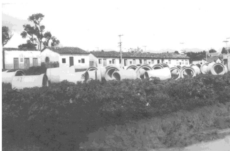
A Praça Castello Branco quando ainda era depósito de tubos
