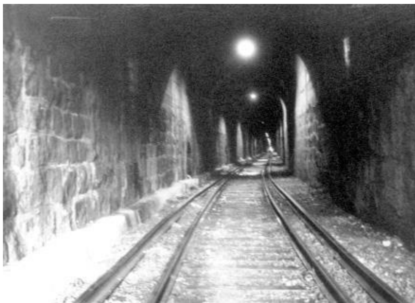
Túnel de Botujuru
