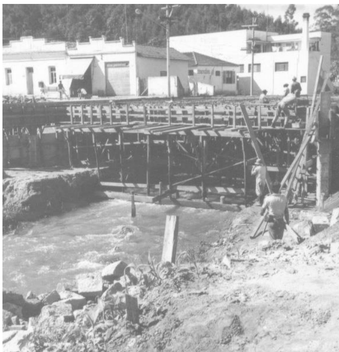
Construção da Ponte da Rua do Comércio (Ponte 29 de Março)
