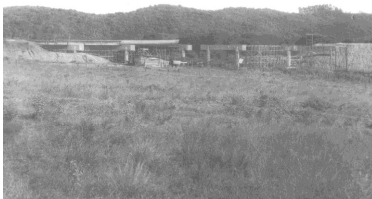
O viaduto interditado, após a queda de uma viga em 1963
