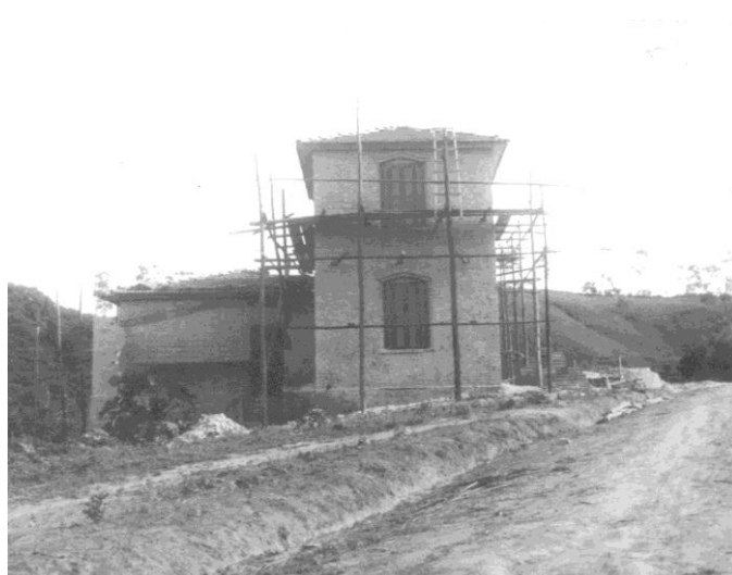
Reforma da casa da Família Ferreira que abrigaria a sede da Prefeitura, antes do surgimento do Jardim Santa Catarina
