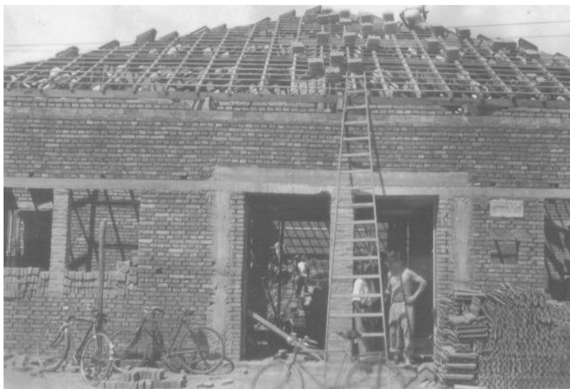
A fachada da sede Esporte Clube Internacional em construção
