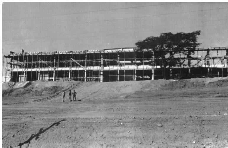
Construção do Colégio Estadual "15 de Outubro"
