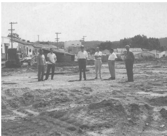
Adherbal vistoria obras da futura Praça Castello Branco
