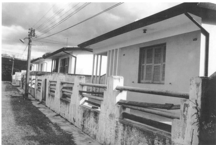
Casario antigo de ferroviários junto à Estação de Campo Limpo Paulista
