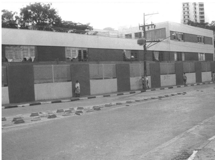
Prédio da EMEF Dr. Francisco Monlevade, já reformado e ampliado
