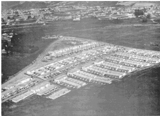
Jardim Marsola logo após a conclusão das edificações
