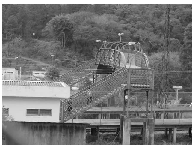
Passarela da Estação de Botujuru, hoje
